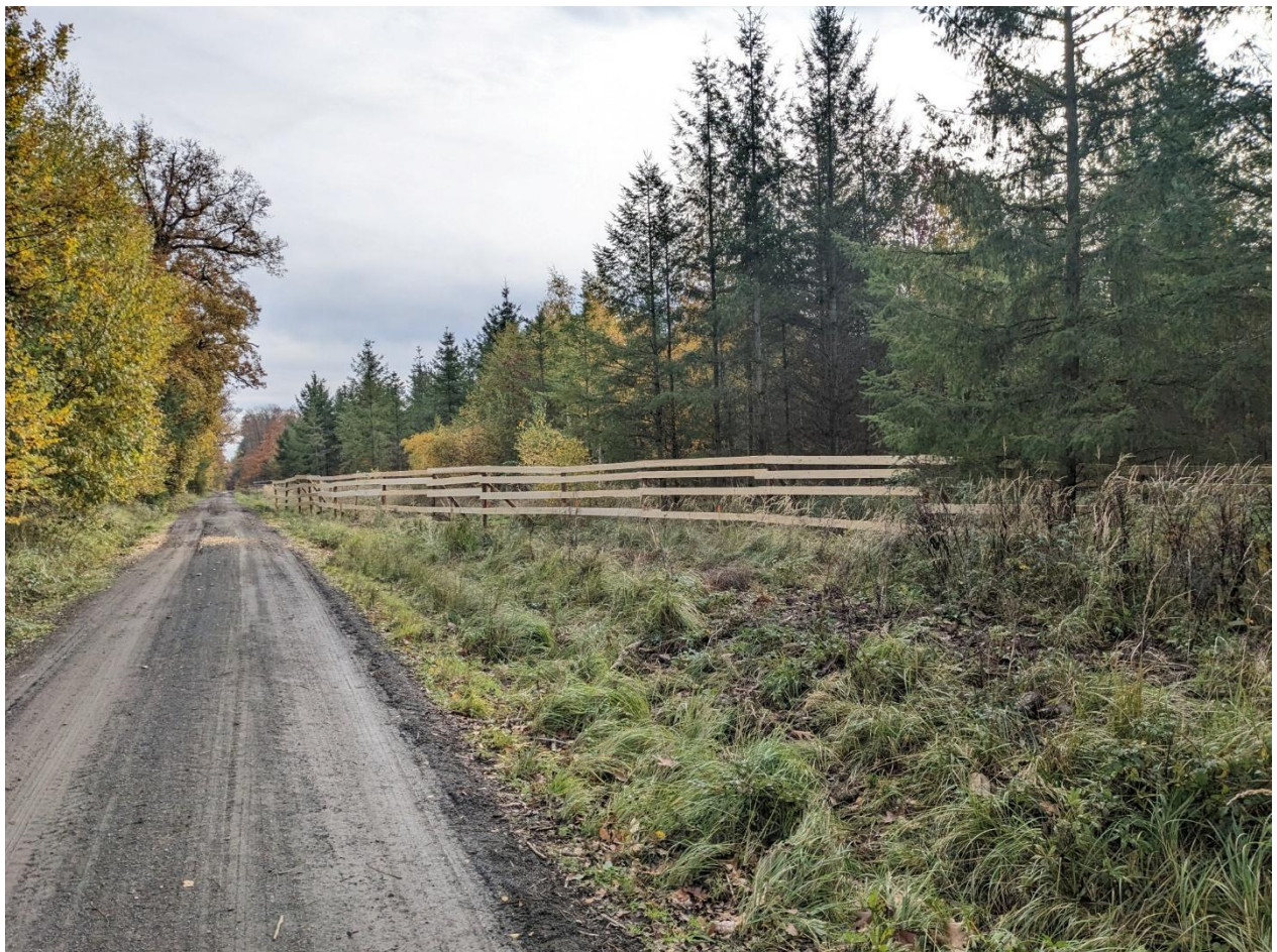
Abbildung: Das bereits errichtet Hordengatter – eine einfache, aus Holzlatten bestehende Abspernung – grenzt sichtbar die Rodungsbereiche ab und schützt vor unzulässigen Eingriffen. Quelle: Qair Deutschland
